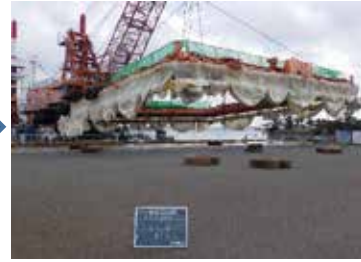
汚濁防止枠撤去状況
