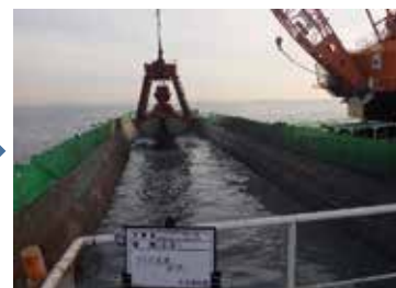
バージアンローダ船排砂状況
