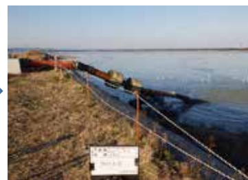
汚濁防止枠撤去状況
